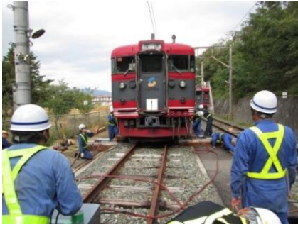
電車脱線復旧訓練 (運輸区・検修)
