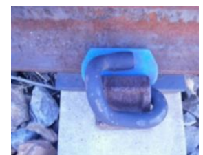
締結装置バンドロール型
