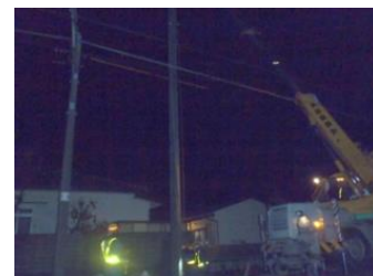
コンクリート柱建替え
